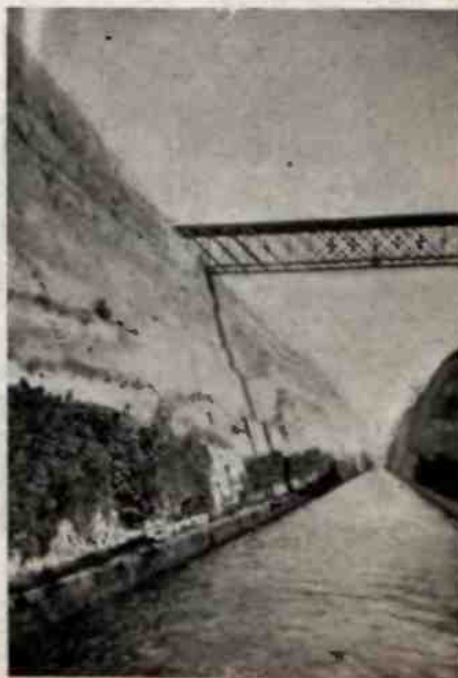
Kanał Koryncki, nad kanałem most.
